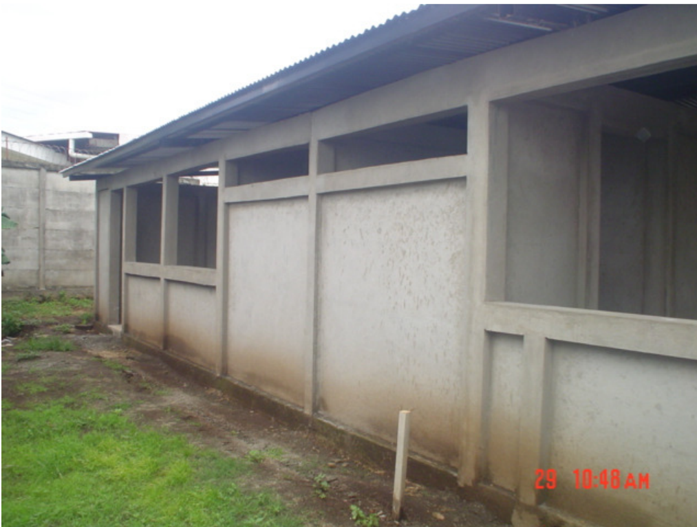
Salón multiusos en fase de construcción, antes de ser pintado
