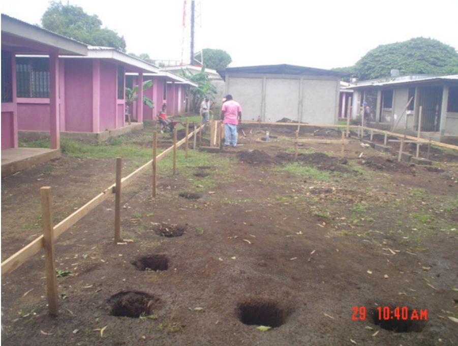
Terreno demarcado para la construcción de los salones infantil y multiusos
